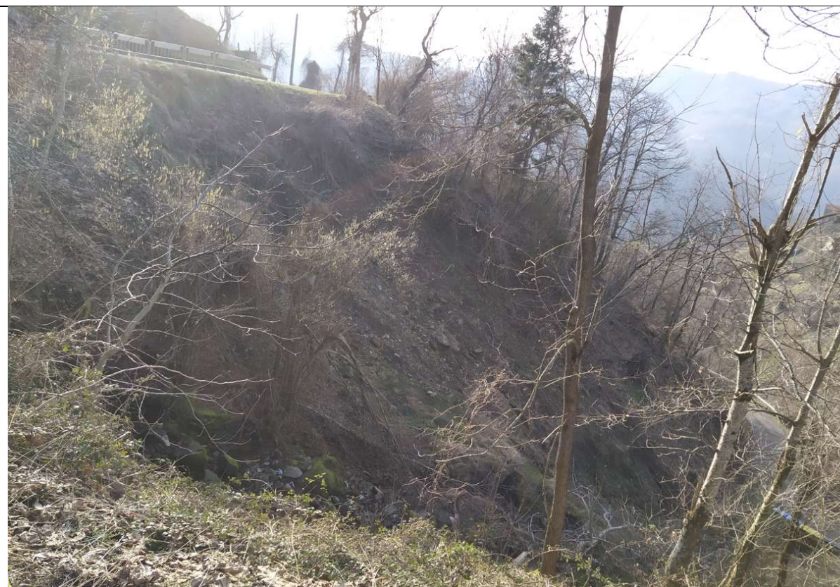
Foto 1 – Corpo di frana
