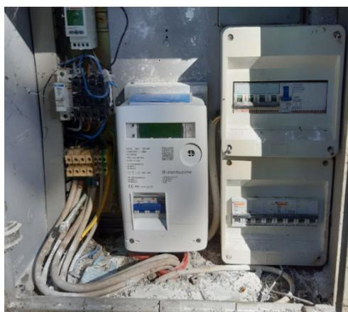
Attualmente è presente un quadro interno all'armadio esistente e considerando che l'armadio è utilizzato in modo promiscuo anche dal contatore, non è possibile mantenerlo, pertanto si provvede alla realizzazione di un armadio stradale esterno avente le seguenti dimensioni 580 mm (larghezza) x 883 mm (altezza) x 330 mm (profondità) con grado di protezione IP55 comprensivo di zoccolo alla base per appoggio dello stesso.
