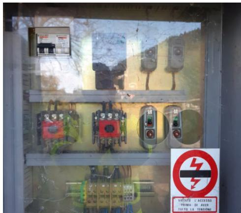
Attualmente non è presente alcun quadro interno all'armadio esistente e considerando che lo stesso non è in buono stato di manutenzione, non è possibile mantenerlo, pertanto si provvede alla realizzazione di un armadio stradale esterno avente le seguenti dimensioni 580 mm (larghezza) x 523 mm (altezza) x 330 mm (profondità) con grado di protezione IP55 comprensivo di zoccolo alla base per appoggio dello stesso.
