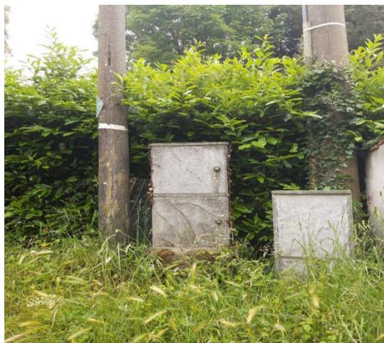
Attualmente non è presente alcun quadro interno al vano esistente, però esiste lo spazio per poterlo installare. L'armadio di contenimento e il basamento risultano in buono stato, per tanto non si prevede la loro sostituzione.
