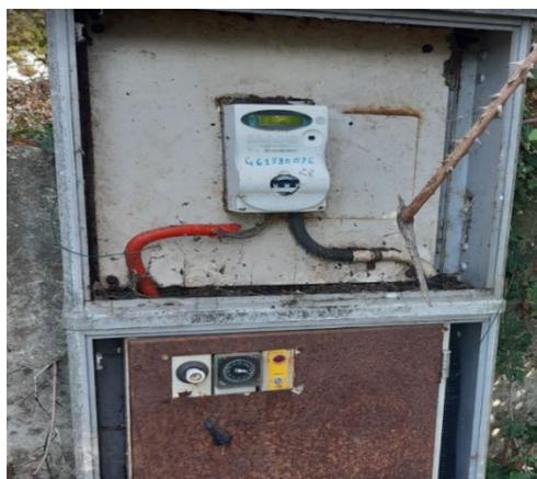
Attualmente non è presente alcun quadro interno all'armadio esistente e, e in considerazione del vetusto stato di manutenzione, non è possibile installarlo, pertanto si provvede alla realizzazione esterna di un armadio stradale avente le seguenti dimensioni 580 mm (larghezza) x 523 mm (altezza) x 330 mm (profondità) con grado di protezione IP55 comprensivo di zoccolo alla base per appoggio dello stesso.
