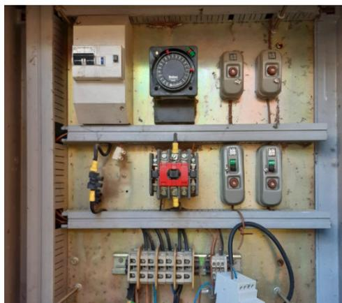
Attualmente non è presente alcun quadro interno all'armadio esistente e considerando che lo stesso non è in buono stato di manutenzione, non è possibile mantenerlo, pertanto si provvede alla realizzazione di un armadio stradale esterno avente le seguenti dimensioni 580 mm (larghezza) x 523 mm (altezza) x 330 mm (profondità) con grado di protezione IP55 comprensivo di zoccolo alla base per appoggio dello stesso.
