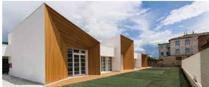
Scuola in legno certificata KLIMAHOUSE tecnologia XLAM a Cascina (PI)
